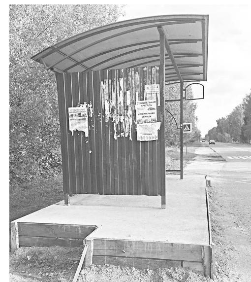
Бетонное основание остановки, которое разрушилось и стало причиной нескольких травм, отремонтировали
